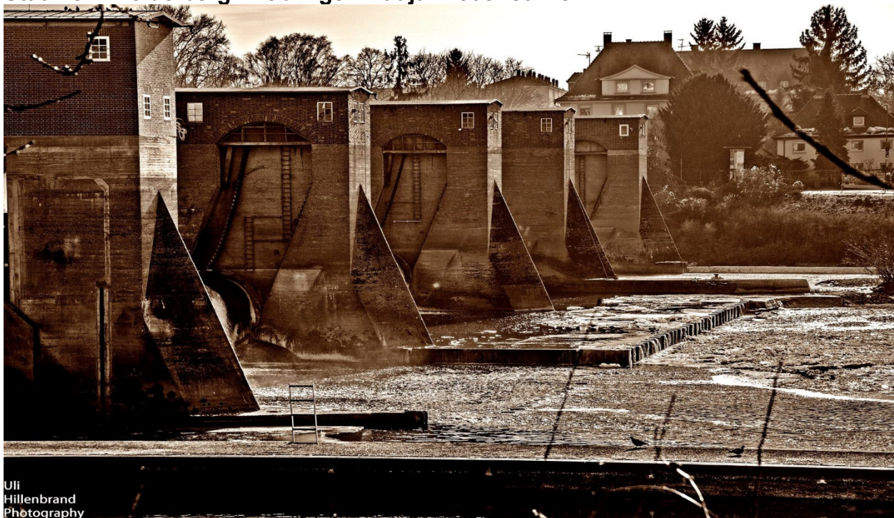
Stauwehr Heidelberg Wieblingen Baujahr 30er Jahre
